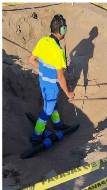
Uno de los operarios trabajando en la búsqueda de la fuga.
