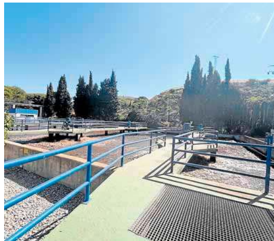
Instalaciones de la depuradora del IARA junto al río Torrox. E. CABEZAS
